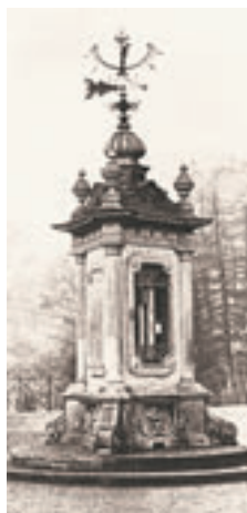
Die Wettersäule unmittelbar nach der Fertigstellung – im Jahre 1883.
